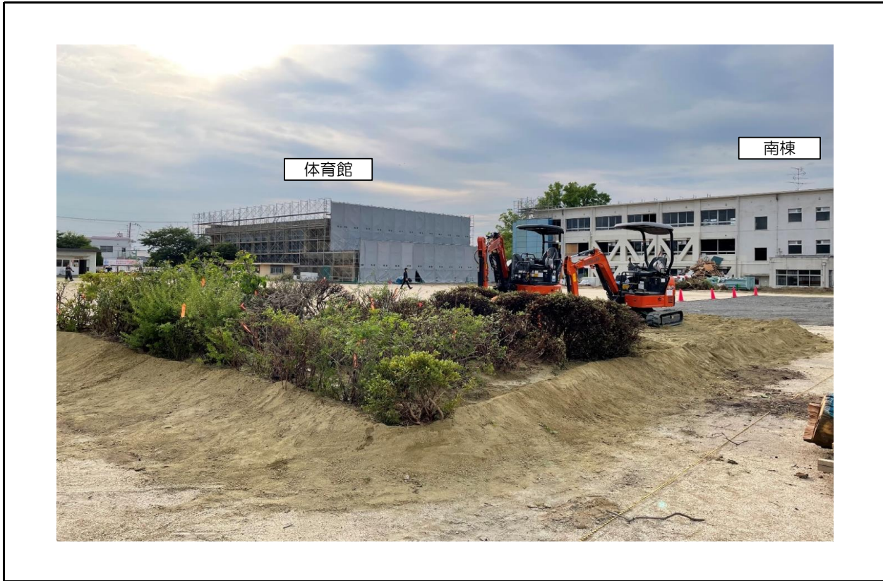
説明 植栽移植状況 撮影箇所 南側より撮影
