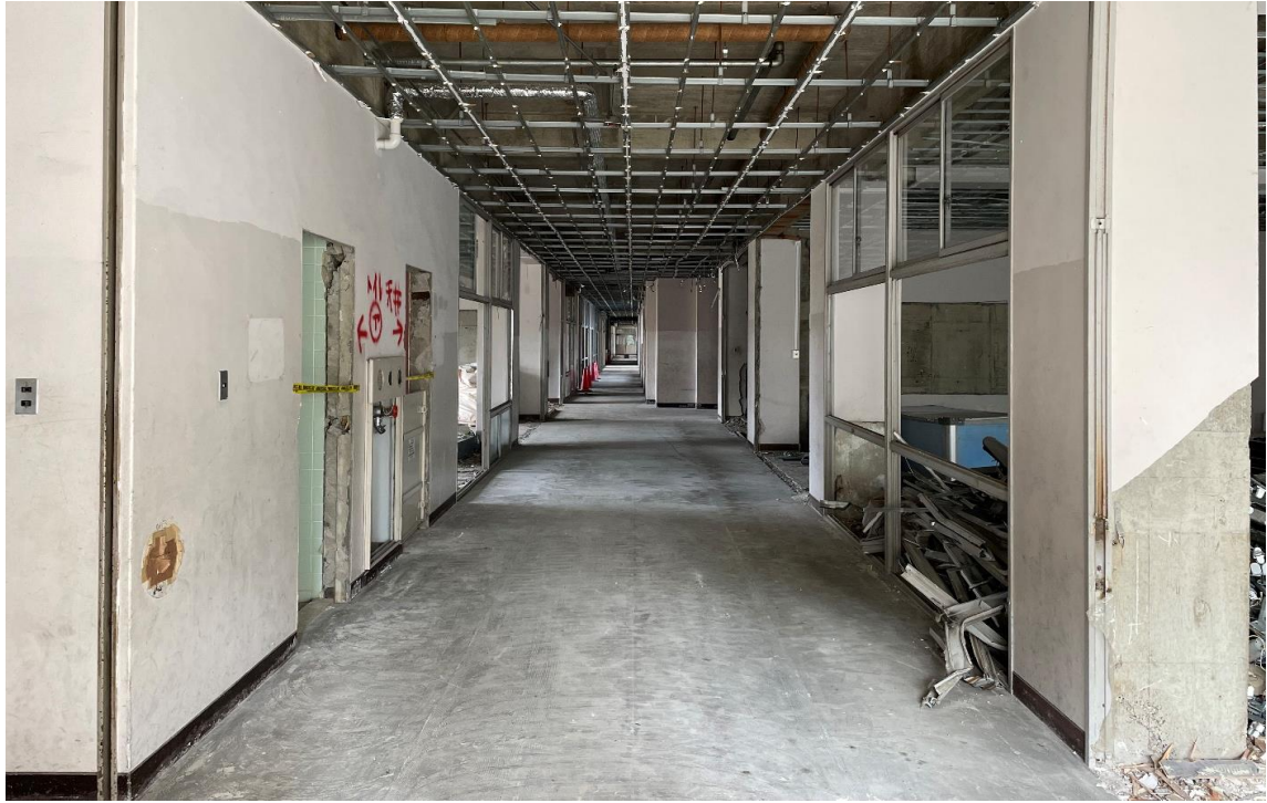
説明 南棟内装解体工事
