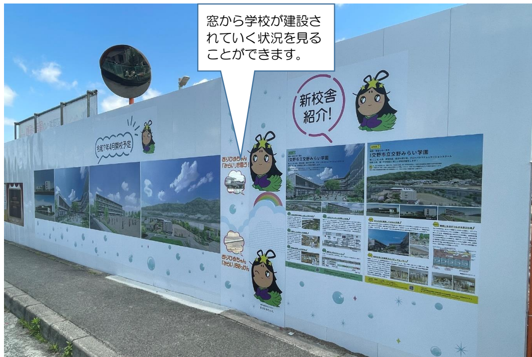
説明 西面仮囲い (新校舎パース・のぞき窓設置状況)
