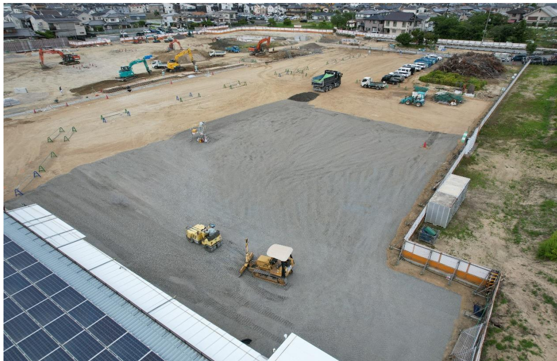
説明 新築準備工事（メイングラウンド）
