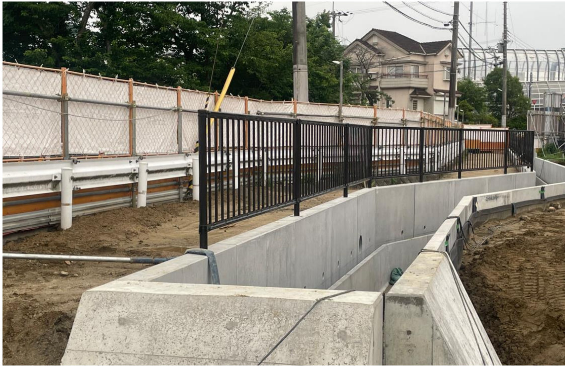
説明 東面擁壁・水路付替工事状況
