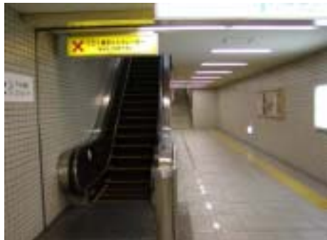
写真3 エスカレーターと誘導ブロック
