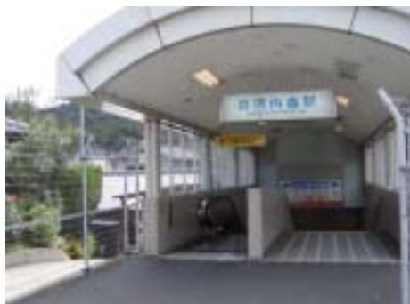
写真1 東側入口とエスカレーター
