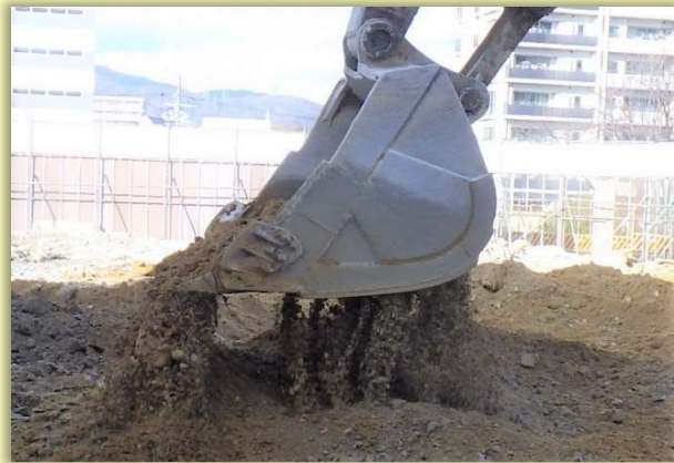
スケルトンバケットを使用するふるい分けの作業（例）
