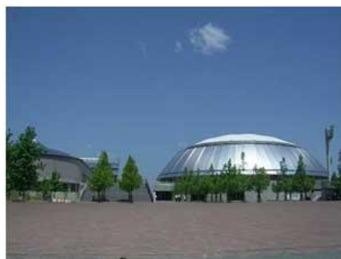
総合体育施設
