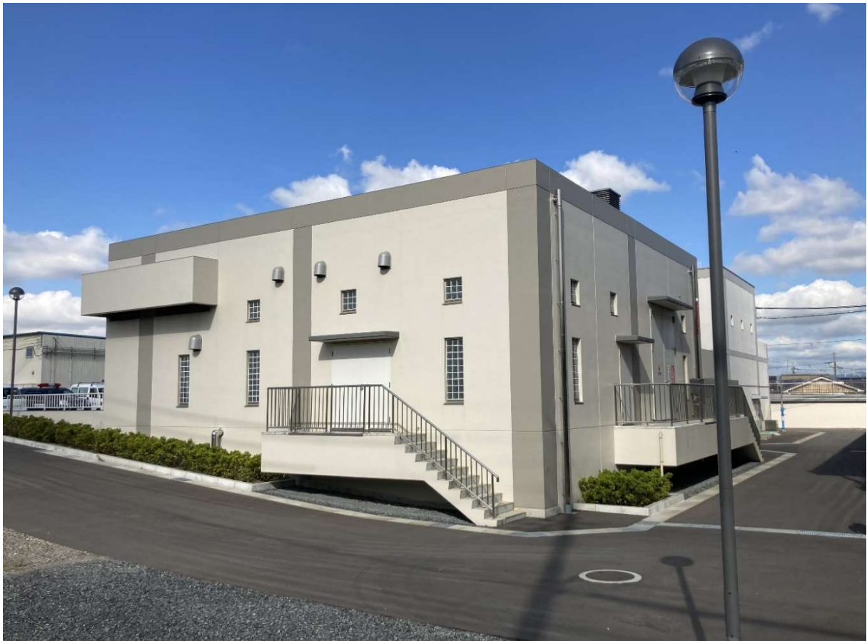
交野市水道局 送水ポンプ棟
