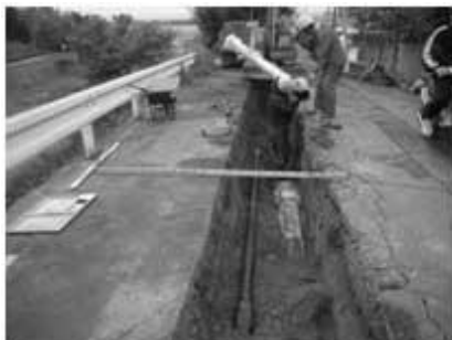
耐震管の敷設作業の様子
