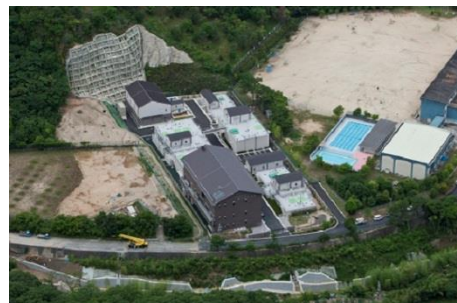
「星の里浄水場」
