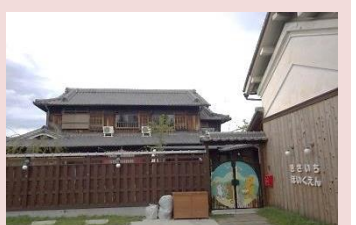
空き家だった古民家を改修
