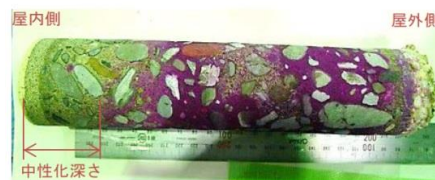
コンクリートの中性化深さ
