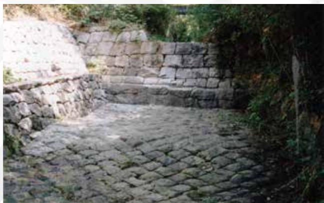
▲ 尺治川砂防堰堤(国登録文化財)
