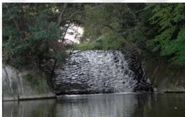
▲ 天野川砂防堰堤(国登録文化財)
