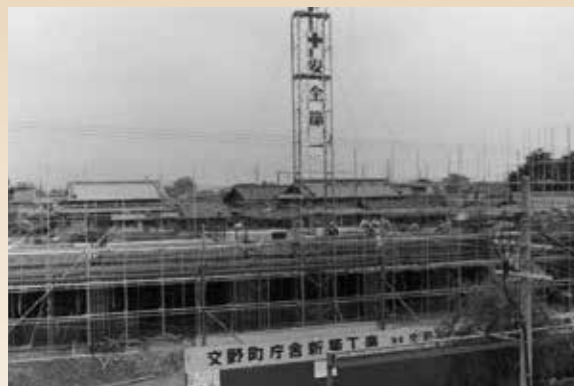
建設中の市役所(1970年) 市になる前年の写真です
