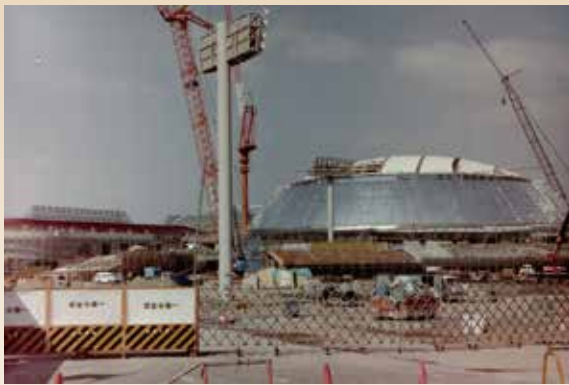
建設中のいきいきランド交野(1997年) 建設時から市民の目を引いていました
