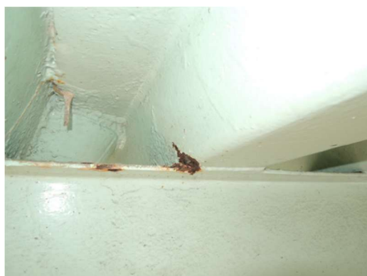
東側橋脚付近床版下面：判定区分Ⅱ変更なし
