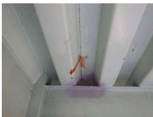
東側橋脚付近床版下面：判定区分Ⅱ変更なし
