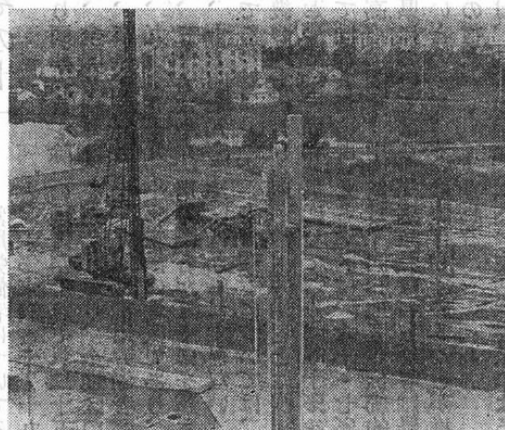
杭打ちの始まった現場
