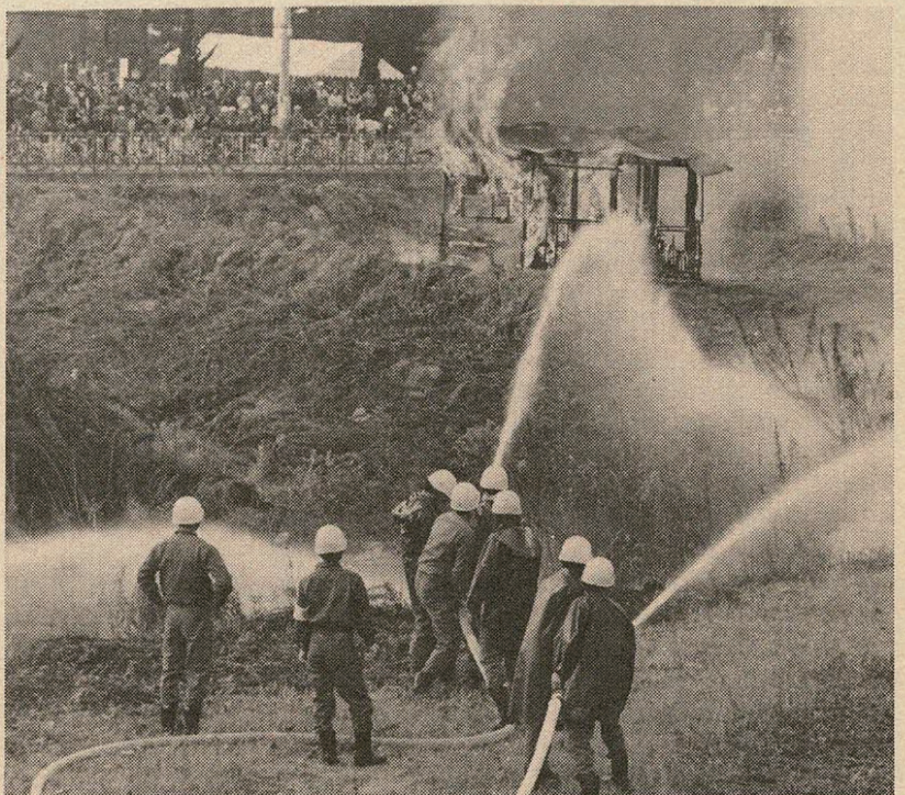
本市の消防力を発揮した模擬家屋消火演習
