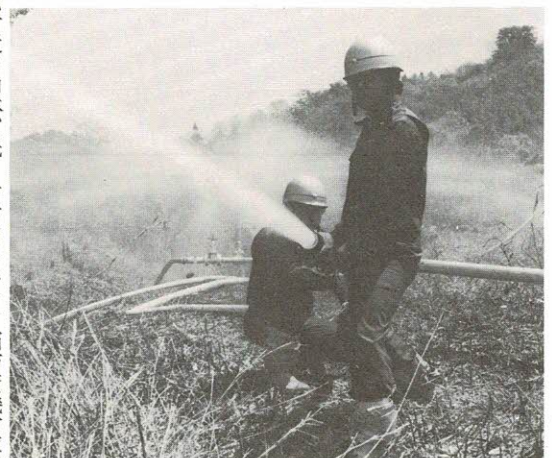
源氏滝宮山消防用パイプライン
