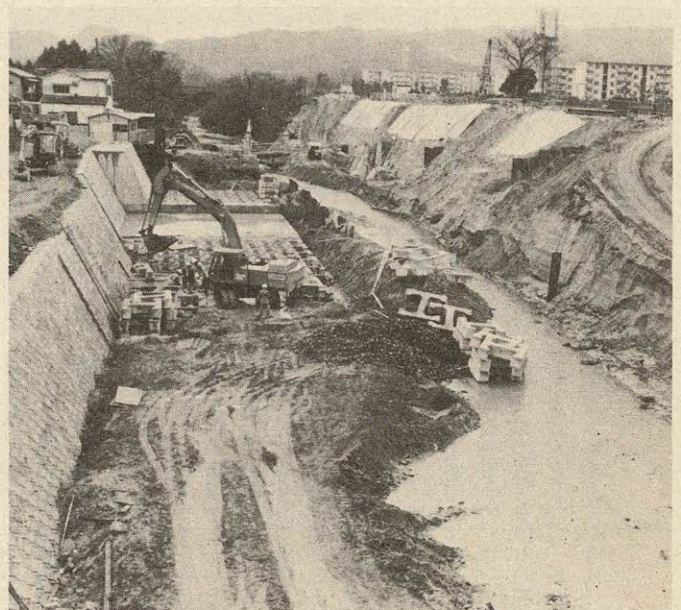
天野川改修工事
