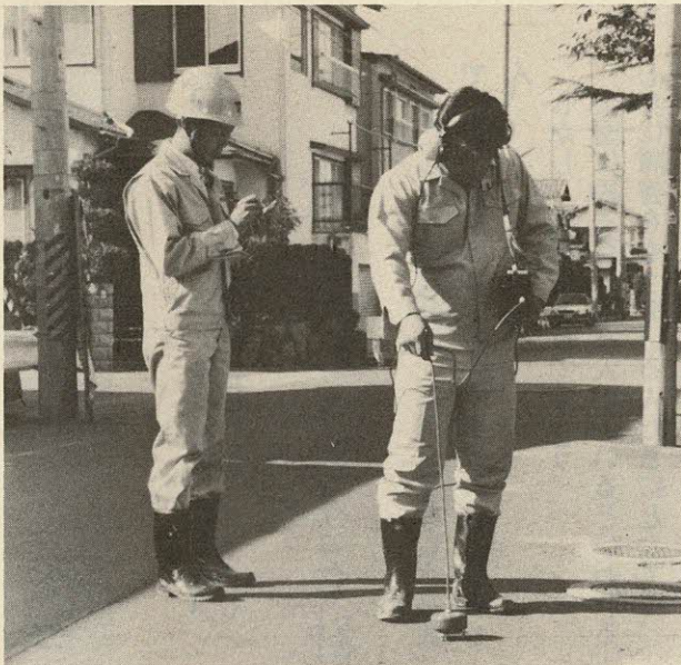
水道管に沿って漏水調査をする職員
