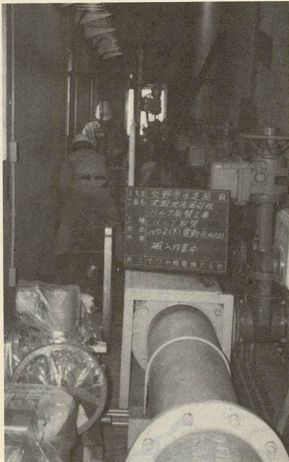
施設の改良工事
