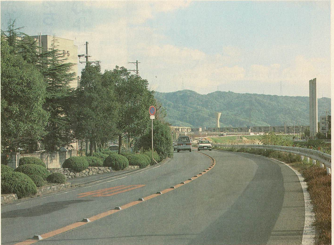
天野川清掃工場付近
