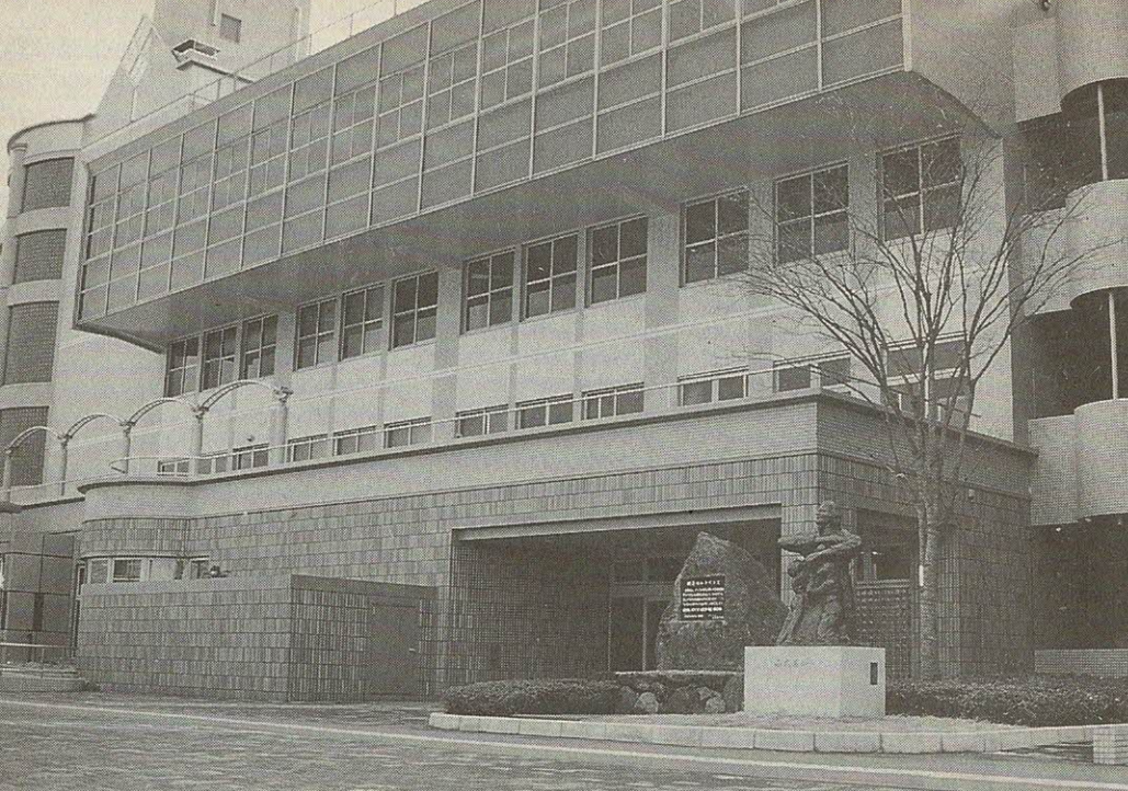
保健福祉総合センター正面(天野が原町5)
