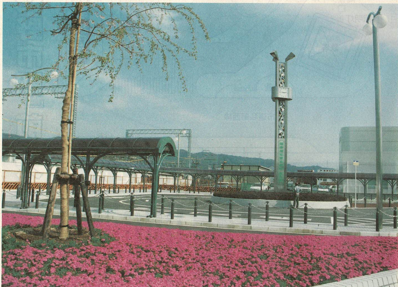
完成した交野市駅西駅前広場
