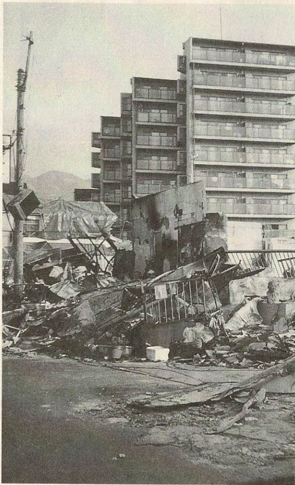
地震で倒壊した家屋（神戸市東灘区魚崎）
