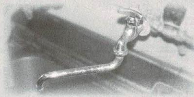
現在は、鉛管を解消するため、道路内部分については、改良工事・修繕工事・家屋の建て替えなどの機会にH I V P管などに置き替えています。14年度末でまだ約9,000戸に鉛管が使用されており、今後も引き続き積極的に置き替えを進めていく予定です。
