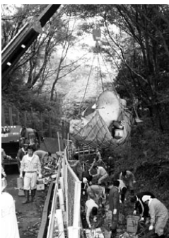
不法投棄ごみの引き上げ作業
