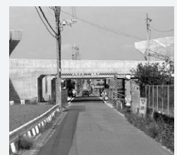
星田高田線に完成したボックスカルバート (7月31日)
