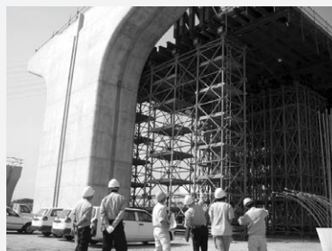
倉治中地区PC上部工事の現地風景(6月20日)
