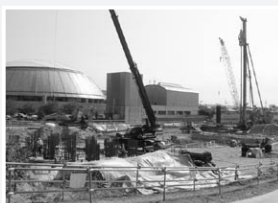
工事が進む「いきいきランド交野」付近
