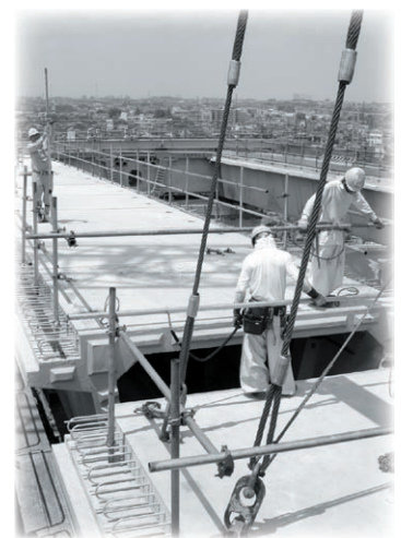
東倉治では、橋脚の上で、橋げたを組み立てる作業が進められていました。
