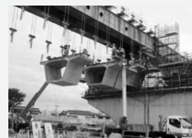
セグメントをつり上げ、 つなぎあわせる
