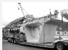
トレーラーで運搬される セグメント
