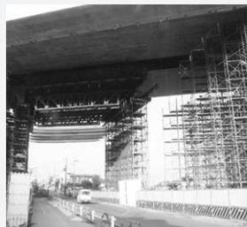
第二京阪道路下の通行者の安全確保のため、交差する一般道路の上に、防護工(写真左)を設置しています。また、ごみや接着剤などの落下対策と作業用として、足場板とシートを設置しています。
