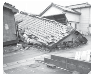
地震で倒壊した家
