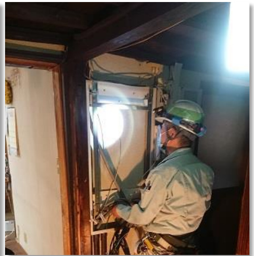
火災報知器の補修（北田家住宅）
