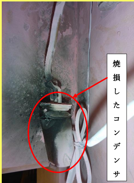
出火した低圧進相コンデンサ
