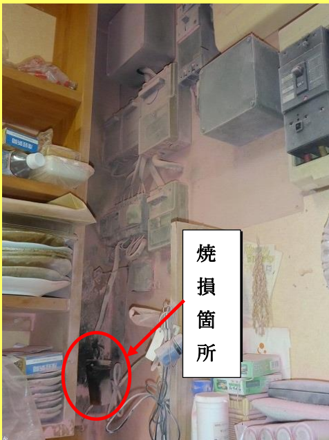
出火した低圧進相コンデンサ
