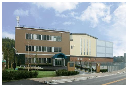
北河内4市リサイクルプラザ (かざぐるま)
