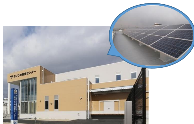
給食センターに設置された太陽光パネル
