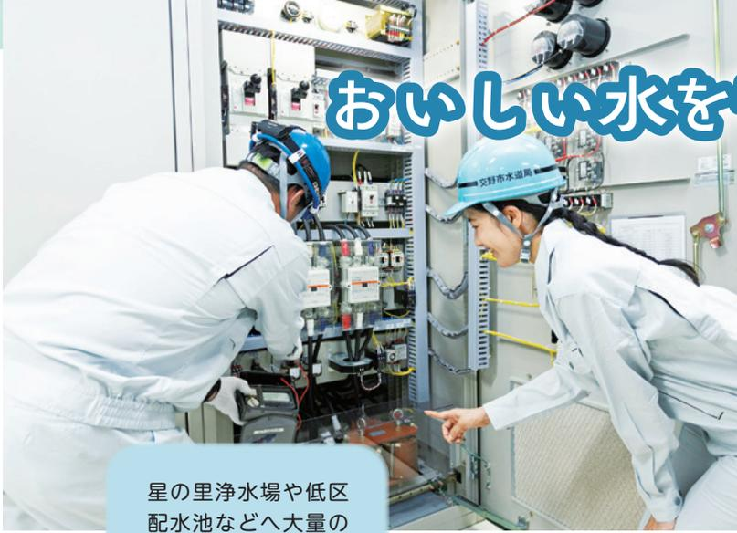
星の里浄水場や低区配水池などへ大量の水を送り出すポンプ（表紙写真の後ろ側に写る設備）と操作盤は、数ある設備のなかでも最重要のもので、特に慎重な保守管理を行っています。
