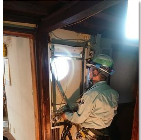
火災報知器の補修（北田家住宅）
