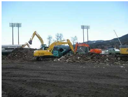
図 4 重機による粗選別 (岩手県宮古市宮古運動公園)
