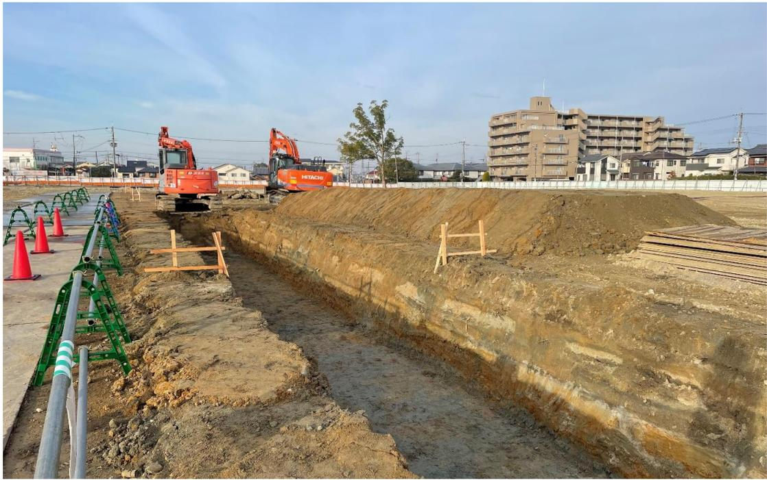
説明 水路付替工事（ホックスカバート部掘削状況）
