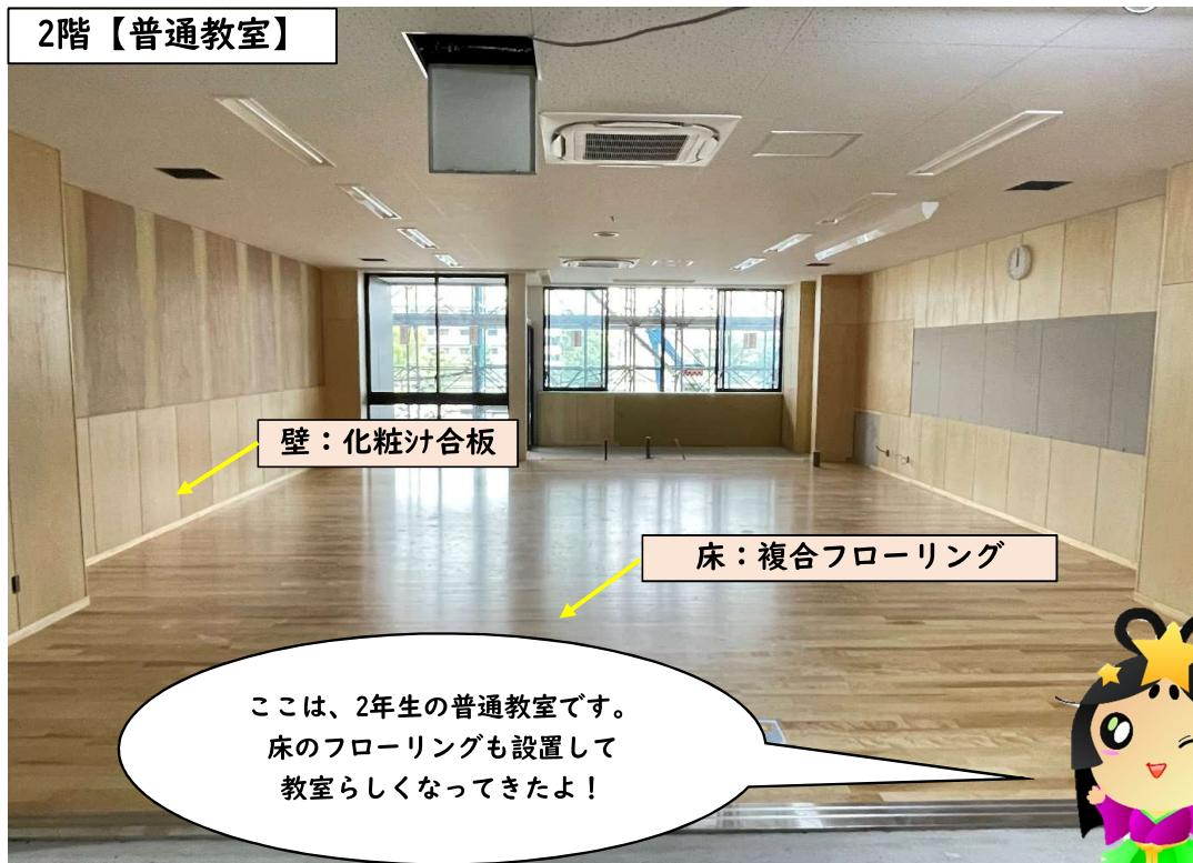
説明 【校舎棟】 2階内部仕上工事状況
