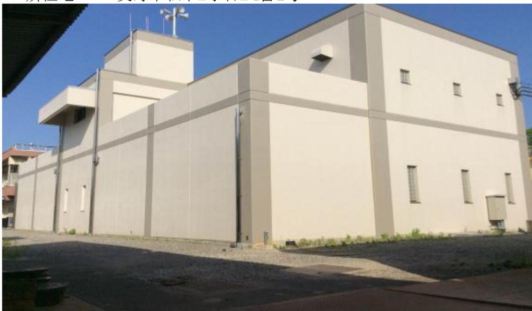
1. 導水ポンプ棟 鉄筋コンクリート造(1階ポンプ室 2階電気室)
