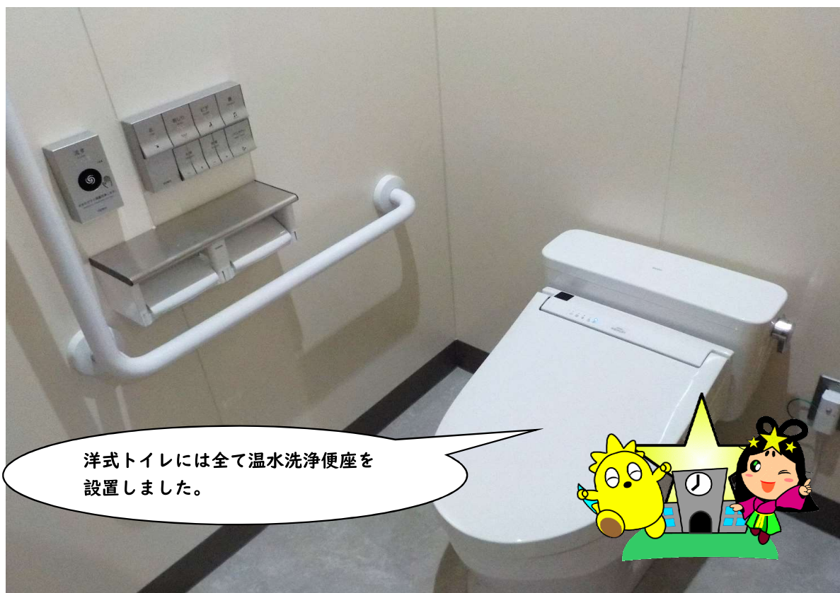
第四中学校トイレ完成 洋式便器
