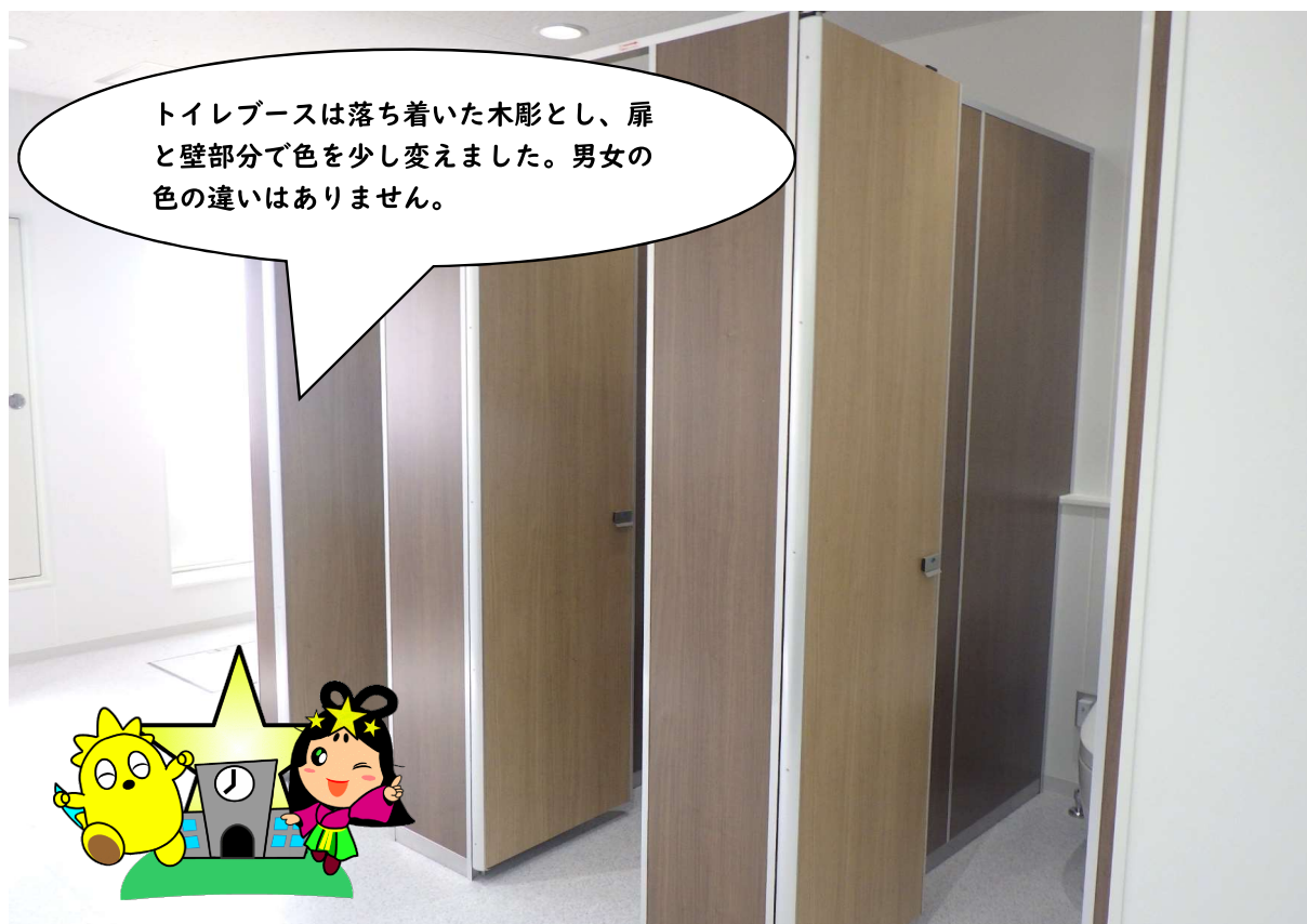
第二中学校トイレ完成 トイレブース
