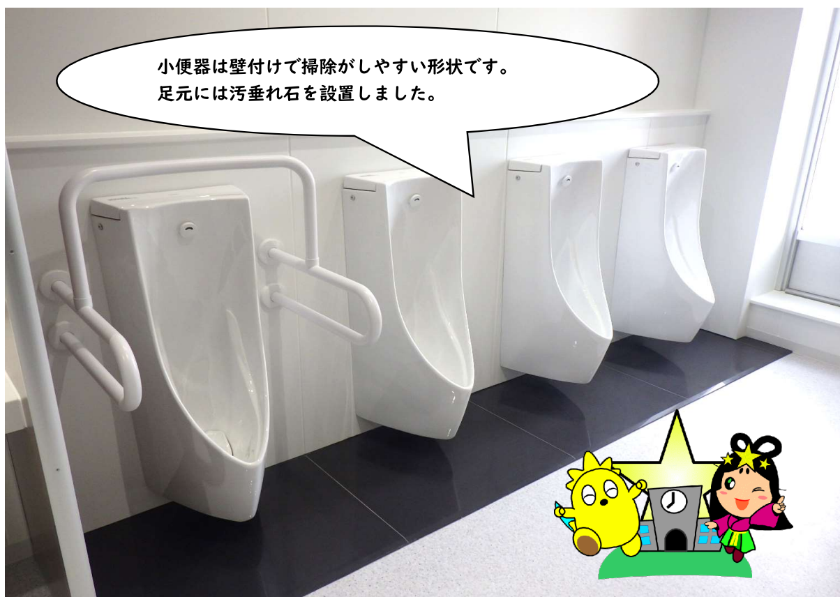
第二中学校トイレ完成 男子トイレ小便器
