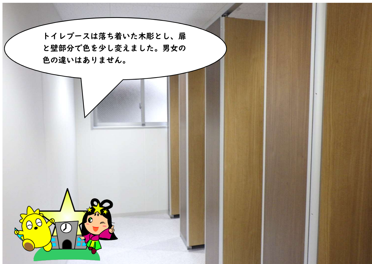
第三中学校トイレ完成 トイレブース
