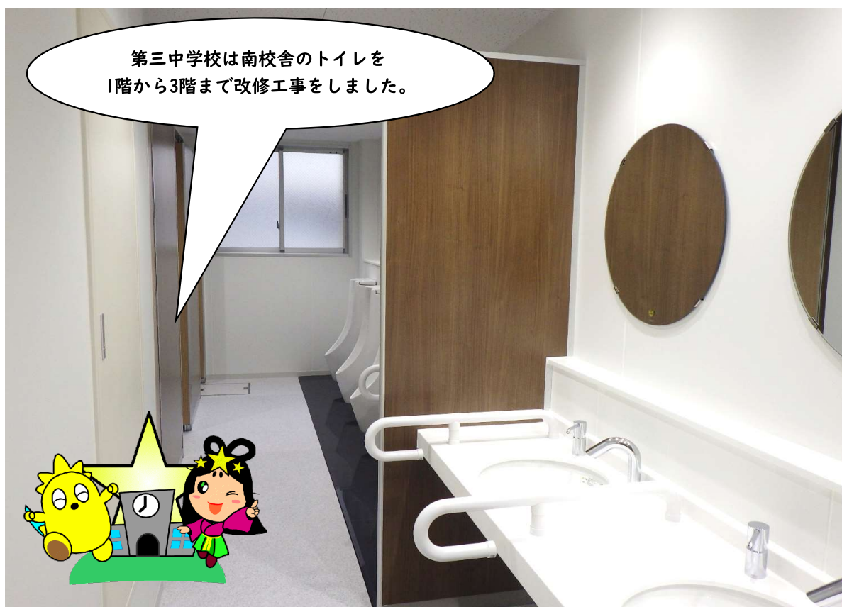
第三中学校トイレ完成 男子トイレ
