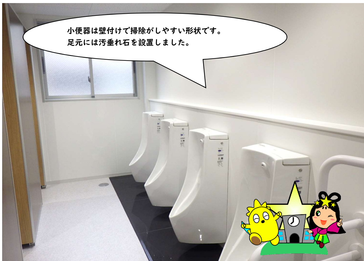
第三中学校トイレ完成 男子トイレ小便器
