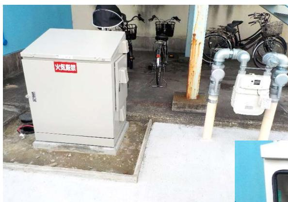
第二中・第三中・第四中は中圧ガスを引き込んだので、校内にガスガバナ（ガス整圧器）を設置しています。
