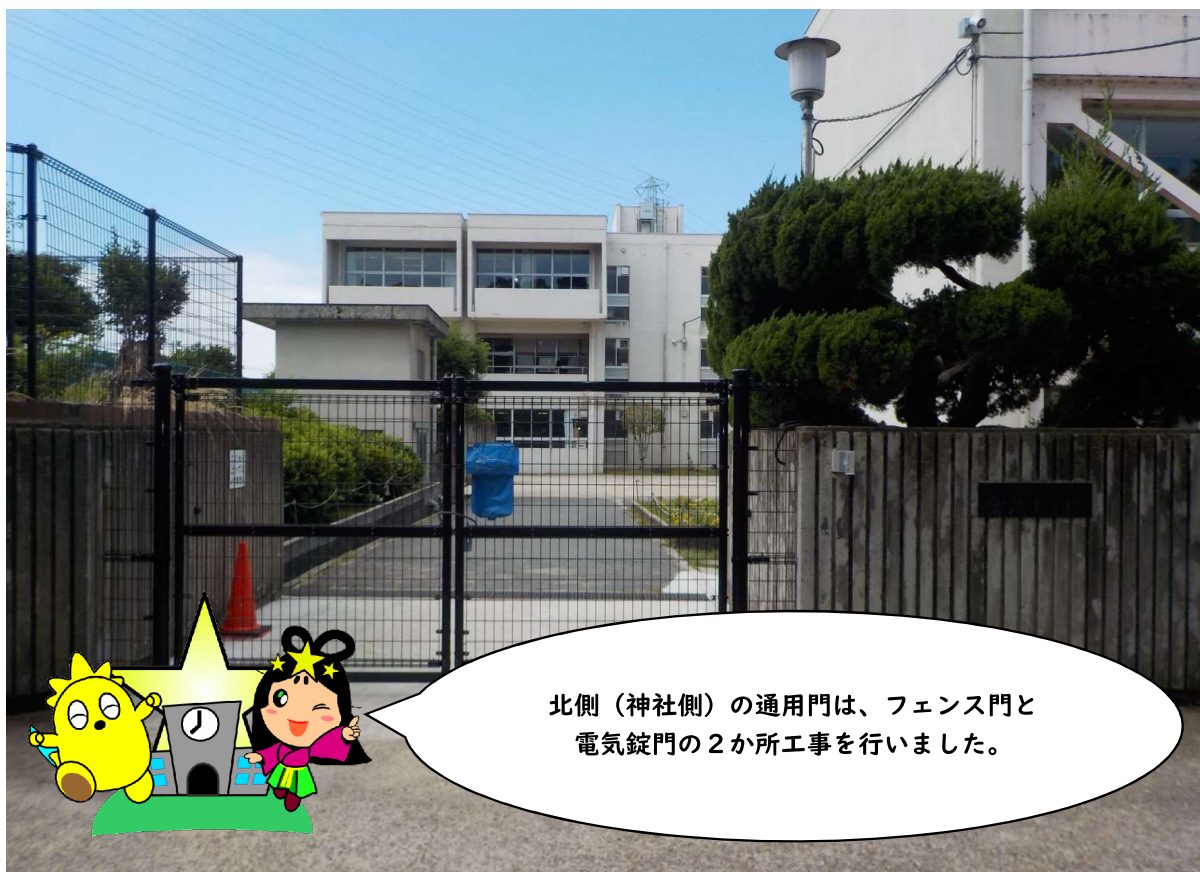
倉治小学校（通用門）門扉改修・防犯設備工事 完了
