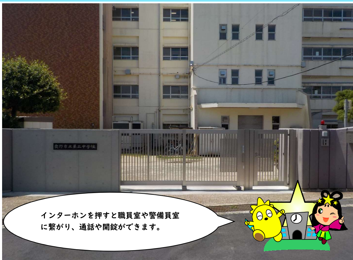
第二中学校（通用門）門扉改修・防犯設備工事 完了
