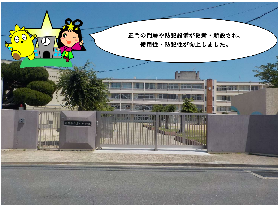
第二中学校（正門）門扉改修・防犯設備工事 完了
