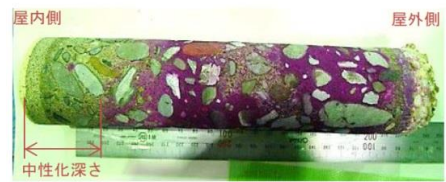
コンクリートの中性化深さ
